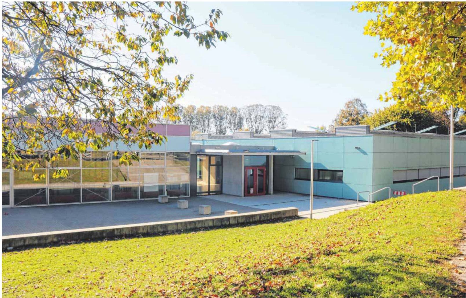
Die Sporthalle aus dem Jahr 1971 soll grundlegend saniert werden.
